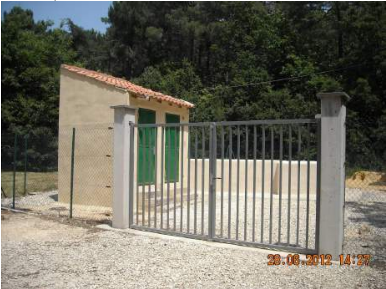
Figure 10 : Portail d'entrée, clôture et ouvrage de captage (Captage d'Estrasson F2)
