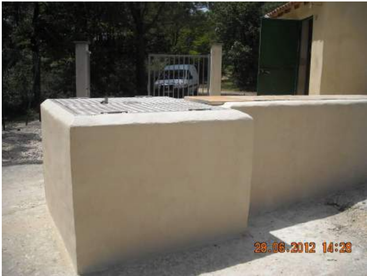
Figure 12 : Protection de l'ouvrage contre les eaux de ruissellement (Captage d'Estrasson F2)
